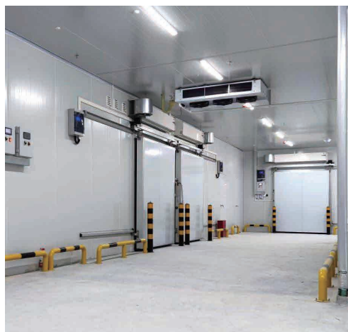
深冷链（保存某些海鲜、生物样本的冷库）中使用的传送装置、自动门推杆中使用的电机
